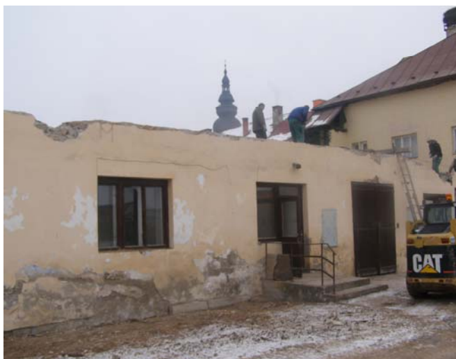
Z budovy požiarnej zbrojnice ostali len obvodové múry pripravené na rekonštrukciu
